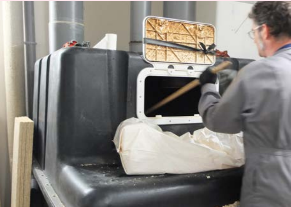
Les toilettes sèches reliées à un composteur demandent une attention régulière de la part d’une personne compétente – ajout de matière sèche, etc.).
