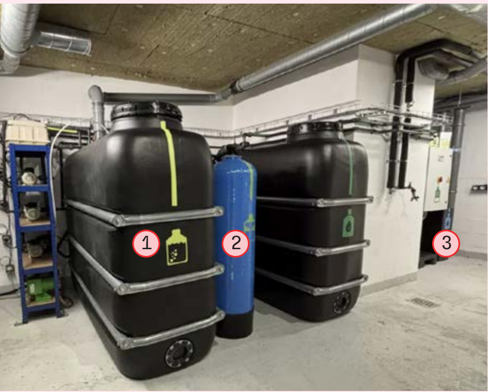
Traitement de l'urine par nitrification (1), filtration (2) et distillation (3) pour concentrer les nutriments présents dans l'urine humaine et obtenir un fertilisant sans odeurs, appelé Aurin. Installation au siège de l'Agence Spatiale Européenne par VunaNexus (C. ESA).
