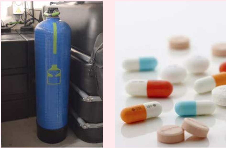
A gauche : filtre à charbon actif installé à l’Agence Spatiale Européenne pour réduire la concentration en micropolluants organiques, et en particulier les résidus médicamenteux, pour la production de l’urinofertilisant Aurin (installation et exploitation VunaNexus). Crédits : L. Raguet. A droite : médicaments. Crédits : L’assurance maladie
