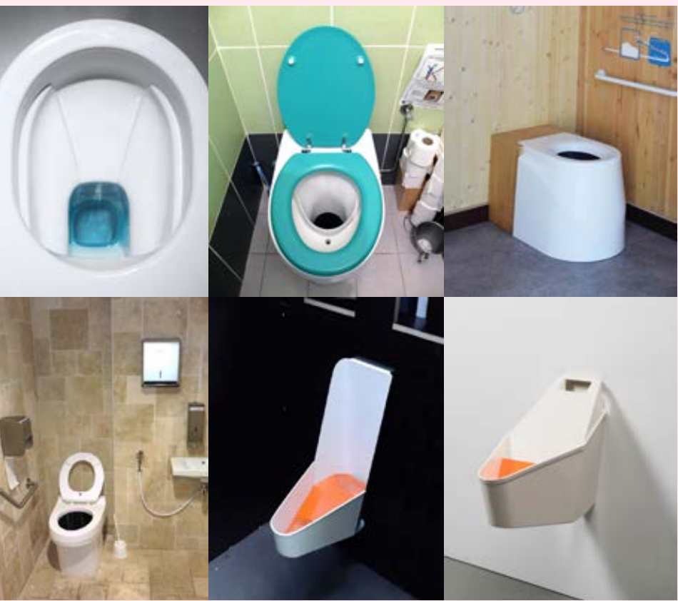
De gauche à droite : toilette à séparation d'urine à chasse d'eau (C. Laufen), toilette sèche à séparation d'urine dans une maison individuelle (C. Louise Ragué), toilette sèche à tapis roulant (C. Ecodoméo), toilette sèche unitaire dans un bâtiment de bureaux à Paris (C. Fabien Esculier), urinoir sans eau unisexe (C. Tribu Architecture), urinoir sans eau féminin (C. Véronique Huyghe).
